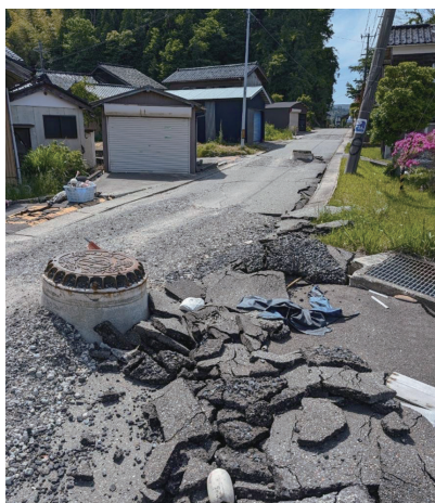
【液状化現象により浮き上がったマンホール】
